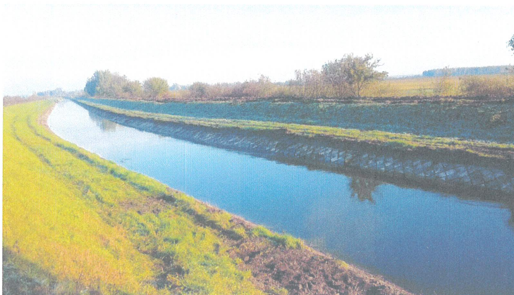
Foto. Nr 1. Kanał Wieprz-Krzna w km 38+000 m. Turowola, gm. Puchaczów
