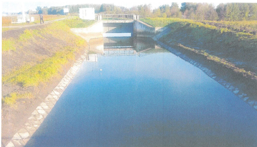
Fot. Nr 3. Widok na jaz żelbetowy na KWK w km 38+270 w m. Dratów, gm. Ludwin
