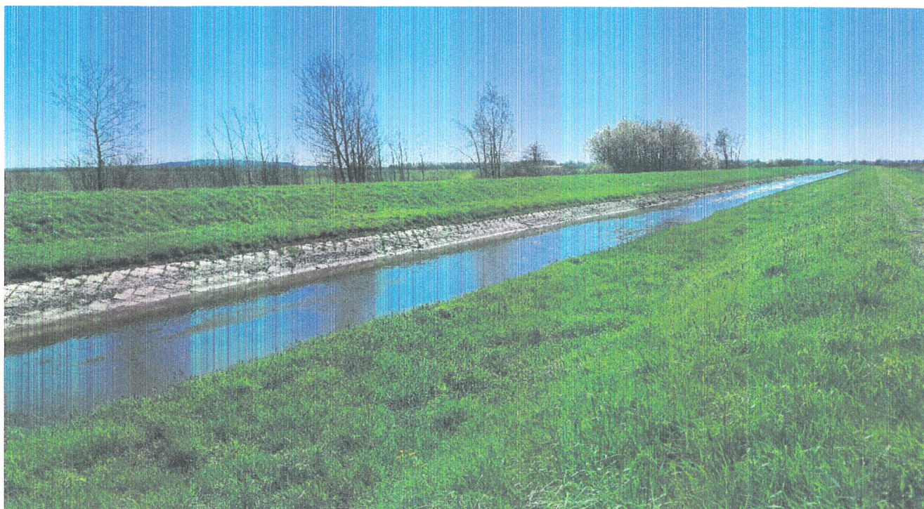
Foto nr 7 Kanał Wieprz- Krzna po odmuleniu i oczyszczeniu z nawisów skarp I przekroju - m. Turowola, gm. Puchaczów
