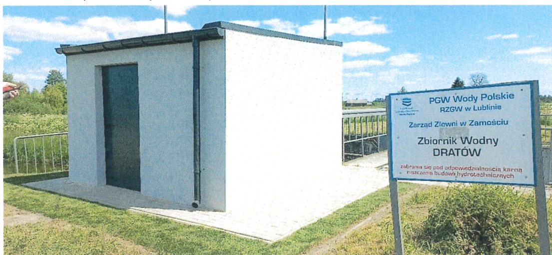
Foto nr 7. Budynek sterowni jazu Dratów po remoncie
