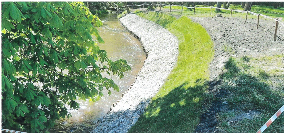
Foto nr 9. Konserwacja rzeki Mogielnica w km 26+988 – 31+500, tj. 4,512 km, pow. chełmski
