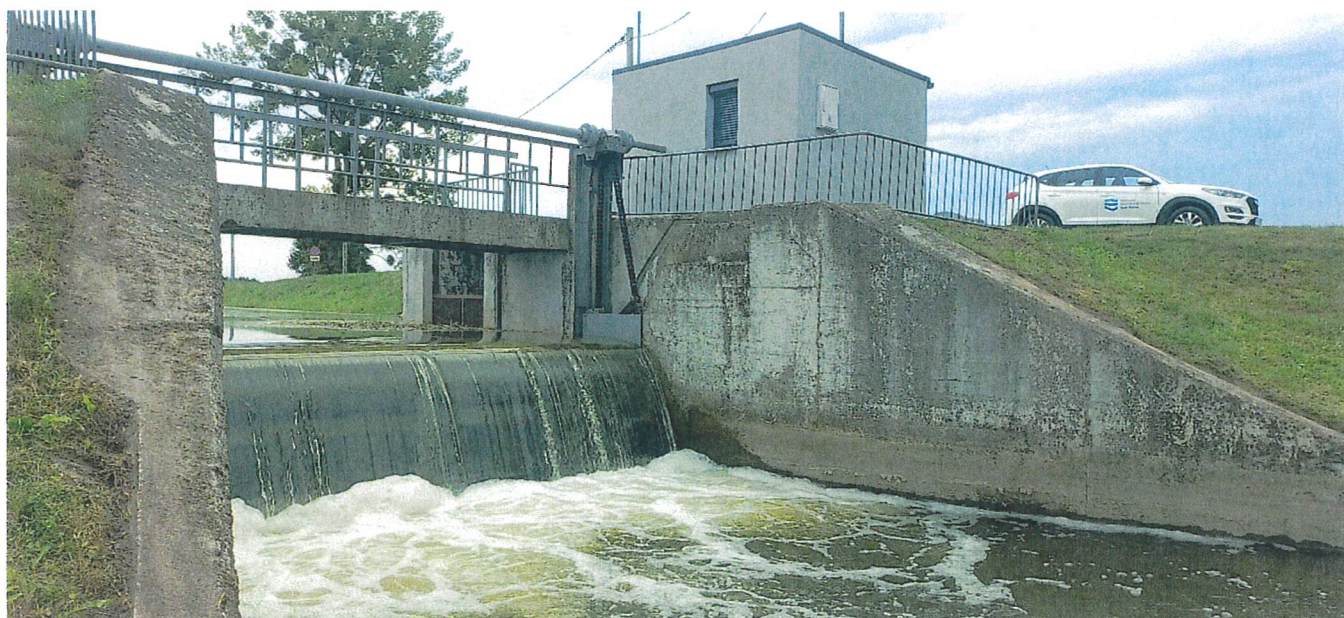
Foto. Nr 1. Kanał Wieprz-Krzna w km 38+270 m. Dratów, gm. Ludwin – spiętrzenie wody na jazie Dratów
