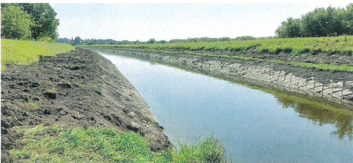
Foto nr 9. Konserwacja Kanału Wieprz – Krzna – roboty odmuleniowe
