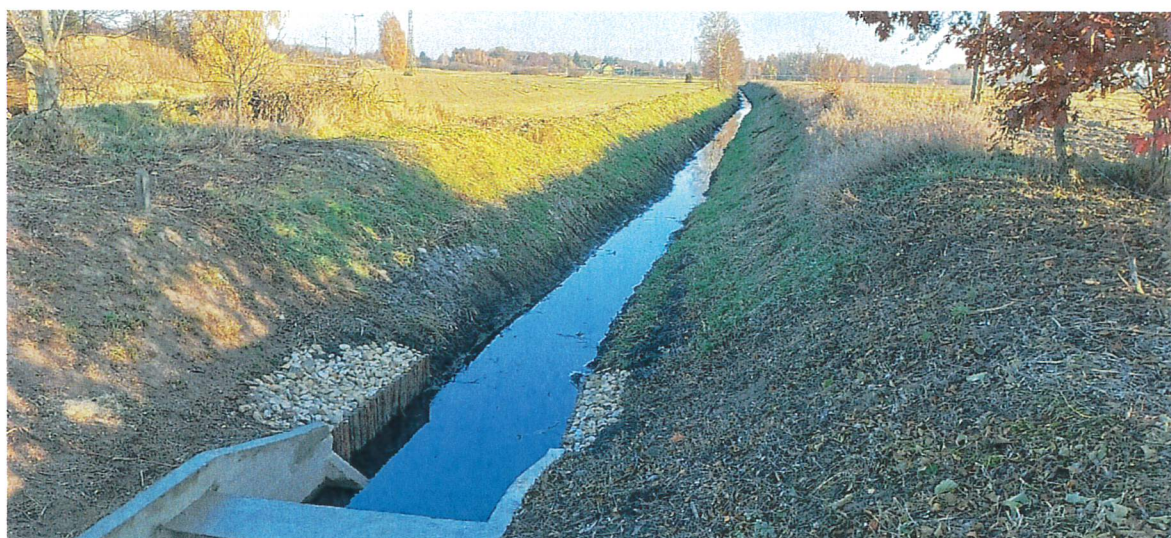
Foto nr 12. Roboty konserwacyjne na Kanale A0
